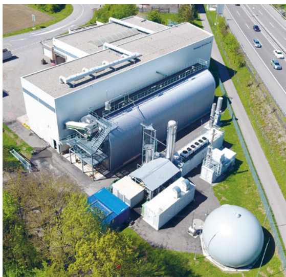
Kompostgas Winterthur AG: Vergärungsanlage mit Fermenter und Gasaufbereitung inkl. Gasspeicher
